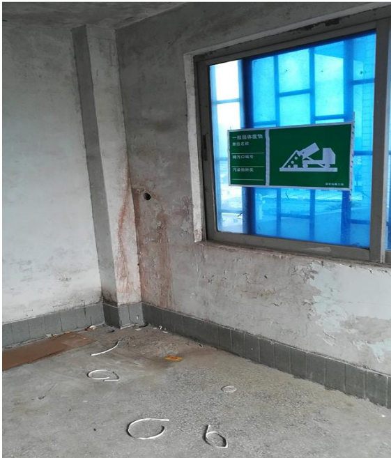
照片4-2一般固废临时存放区
