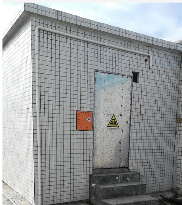
照片4-3危险废物暂存间
