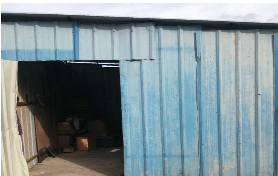
照片 4-1 一般固体废物暂存间
