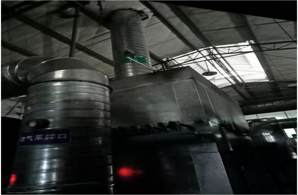
照片 4-4 喷粉废气排放口
