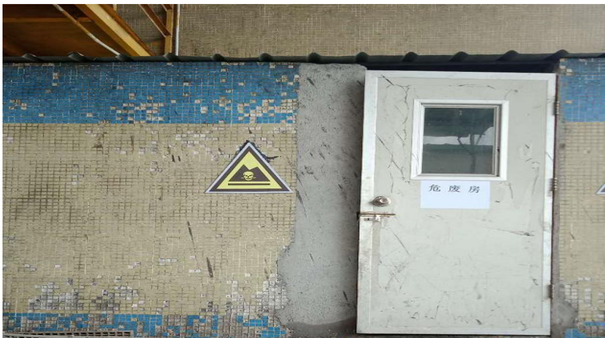
照片 4-3 危险废物暂存间
