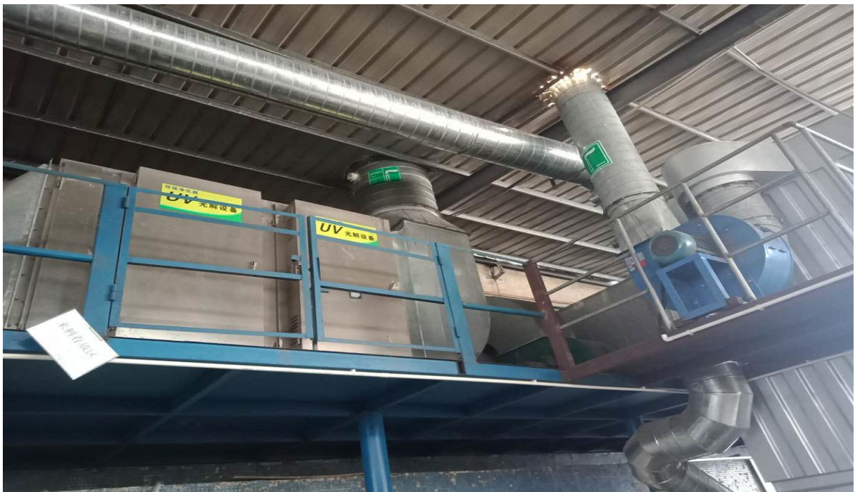
照片 4-5 喷漆烘烤废气排放口
